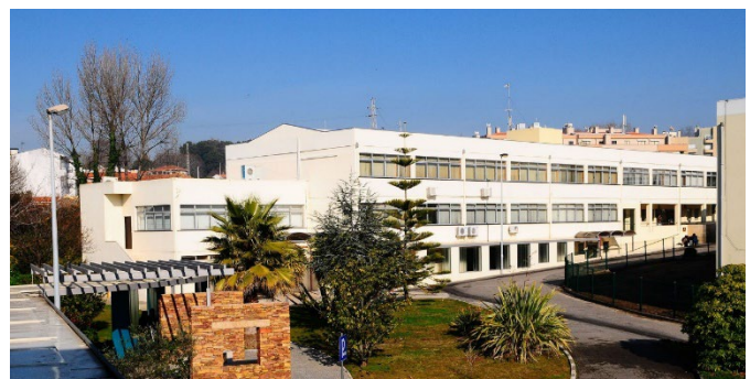
Instalações do CRPG
